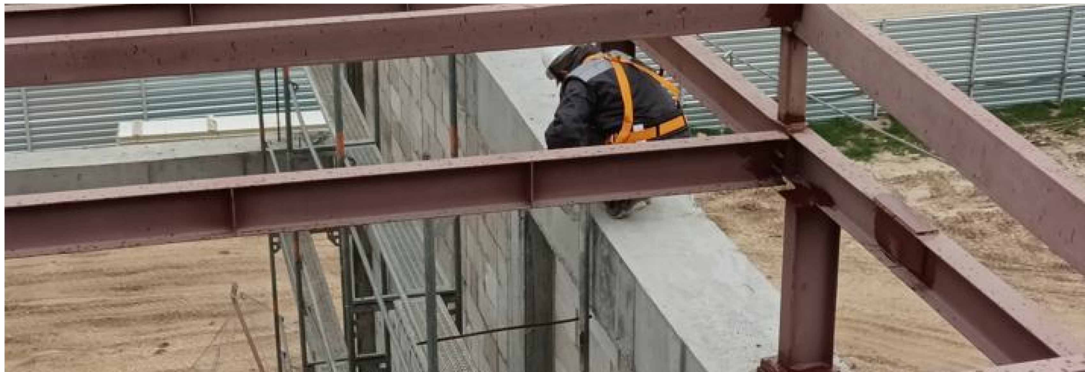
Изготовление и устройство металлоконструкций основания крыши
