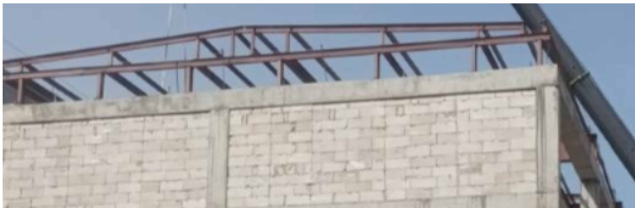
Изготовление и устройство металлоконструкций основания крыши
